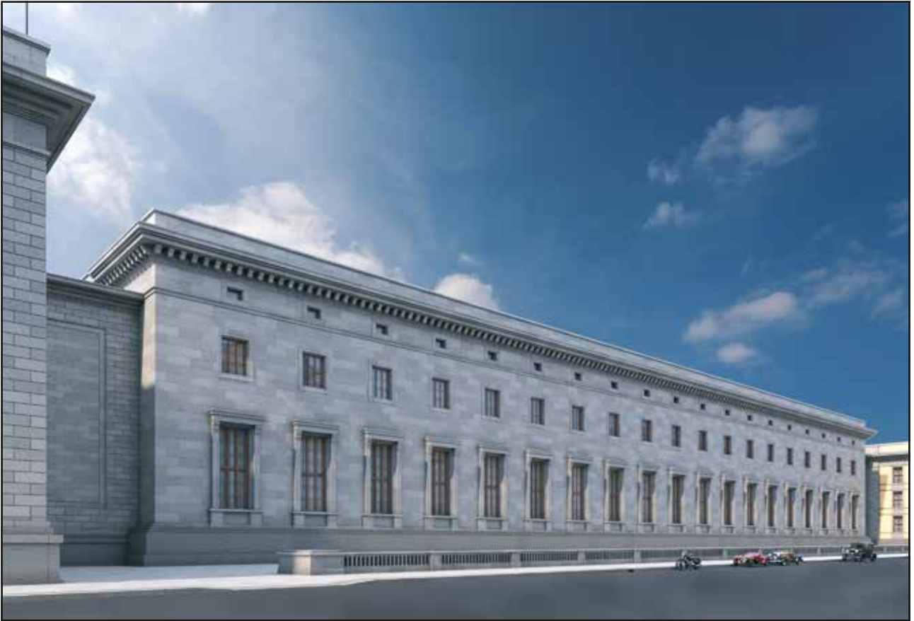
Abb. 58 Die Gestaltung des Mittelbaus täuschte Deckenhöhen vor die nicht der Realität entsprachen
