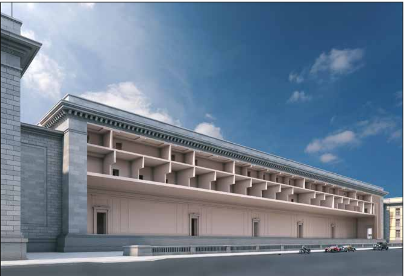
Abb. 59 Dieser Schnitt zeigt, welche Deckenhöhen die Räume hinter der Fassade tatsächlich hatten
