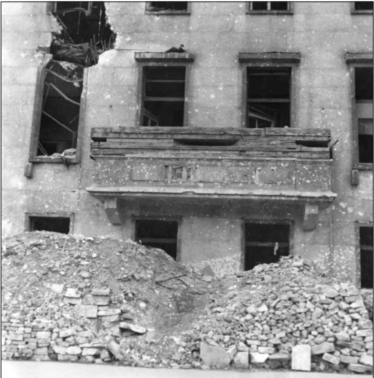
Abb. 104 Dieses am 01.07.1945 aufgenommene Foto zeigt den mit Holzbohlen verstärkten Führerbalkon
